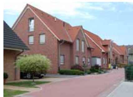
Baugebiet Küferstraße, RE
