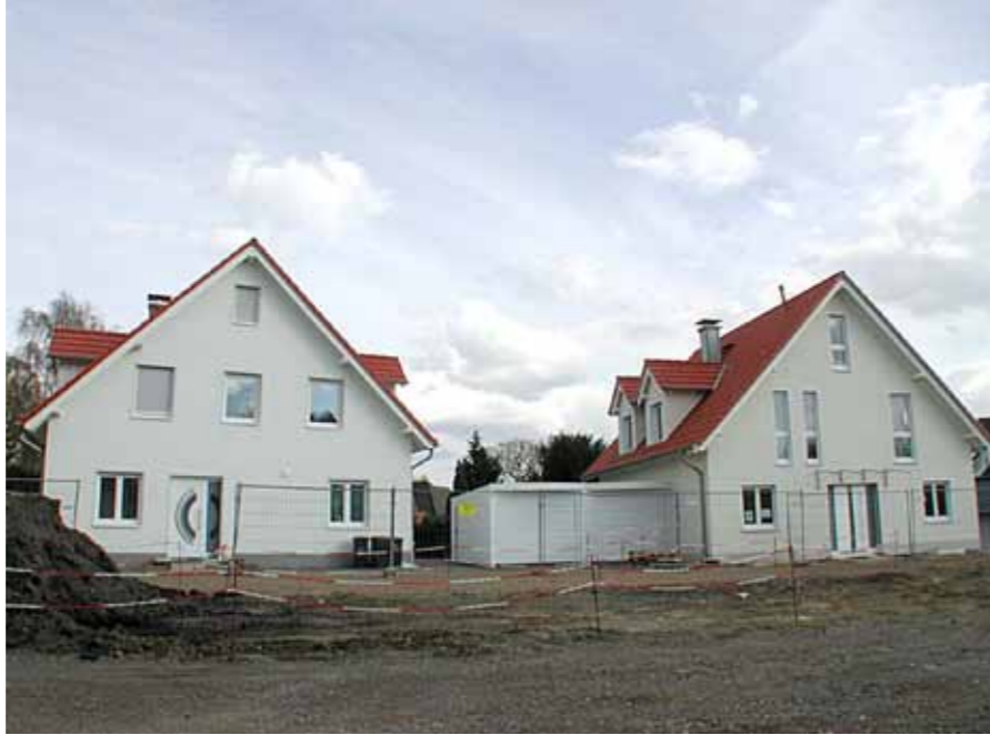
Baugebiet Merklinder Str. 52, C-R
